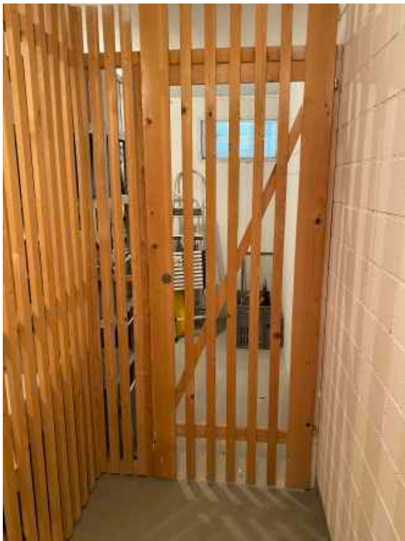
Keller mit Fenster und Stromanschluss
